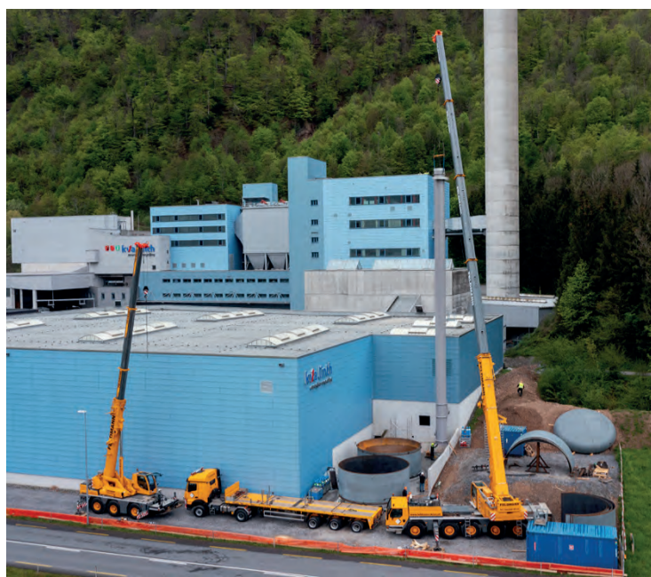
... und die Aufrichtung des Notkessel-Kamins im April.
