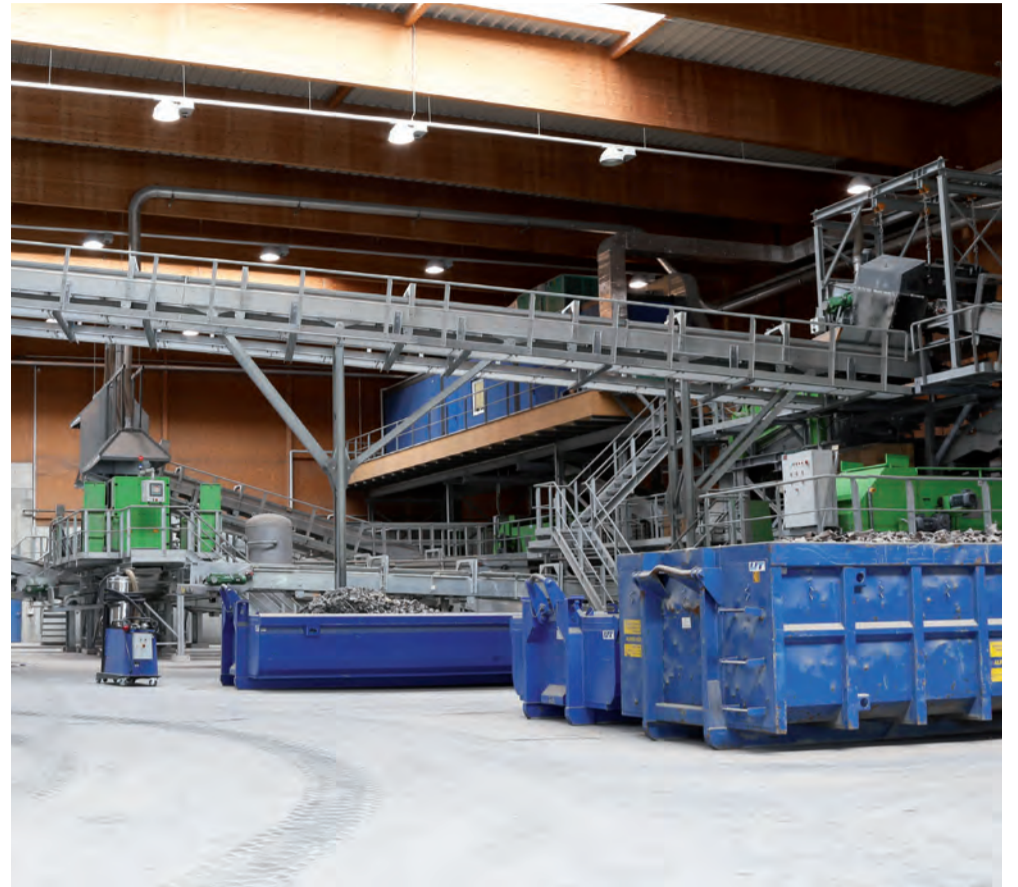
Mit modernen Technologien werden Buntmetalle aus der Schlacke herausgefiltert.
