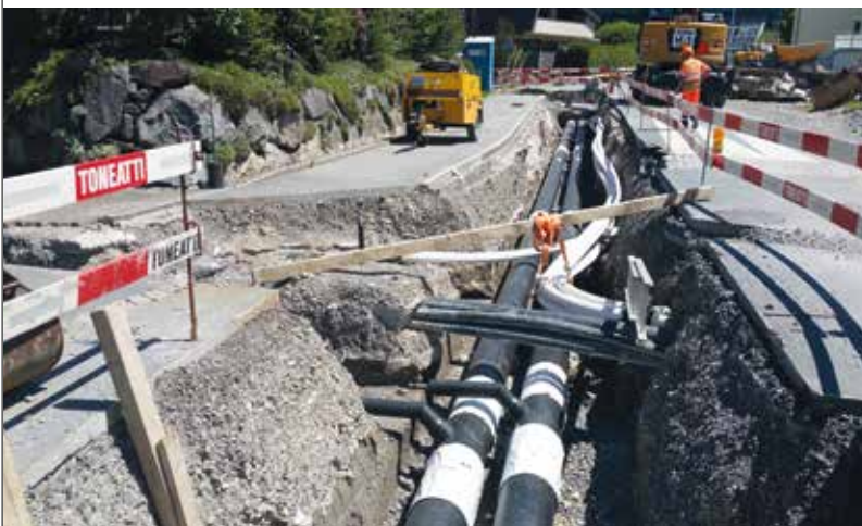
Bau der Fernwärmeleitung
