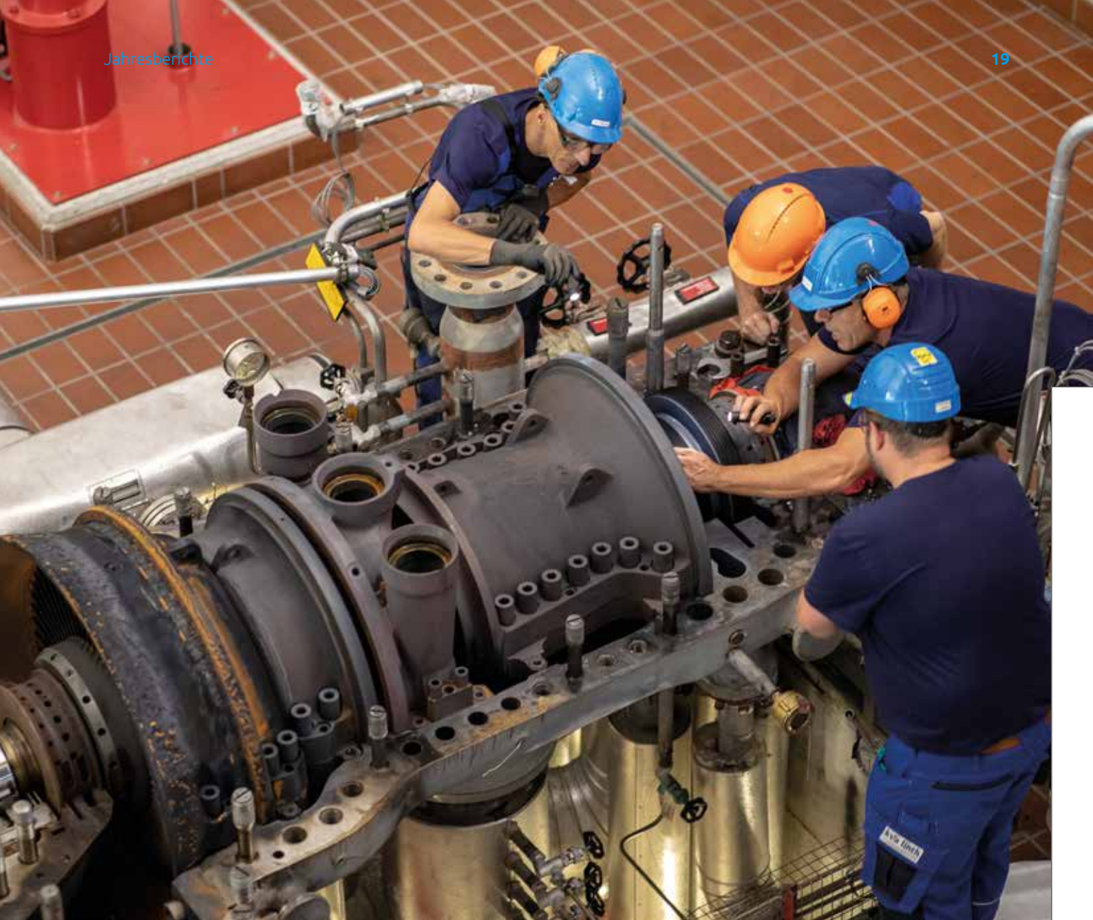
Unterhalt an geöffneter Turbine
