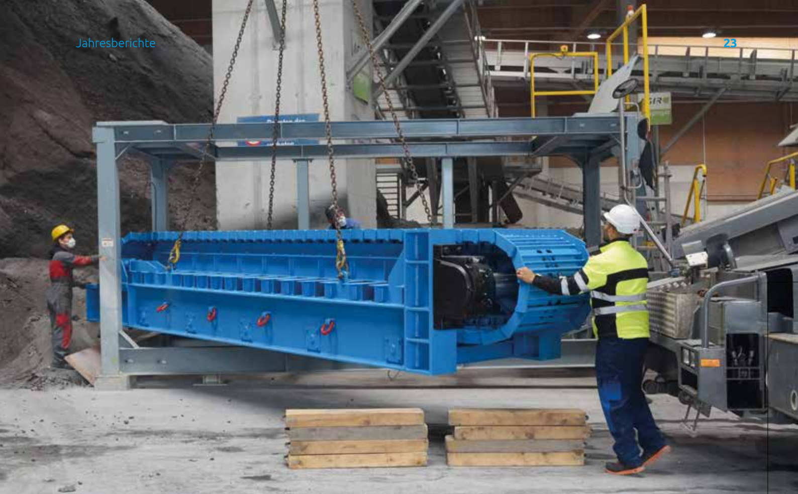
Montage Plattenbandförderer der Feinschlackenanlage
