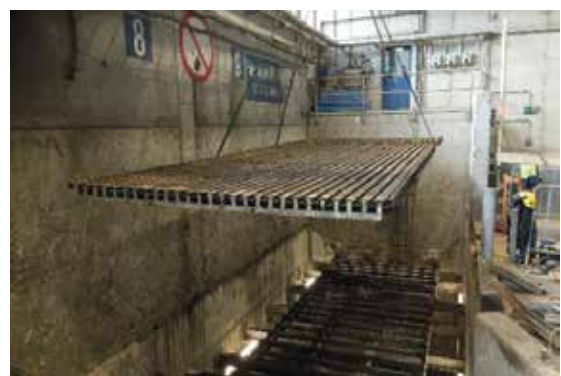
Reparatur Schubboden
