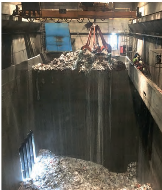
Löscharbeiten im Brennstoff-Zwischenlager
