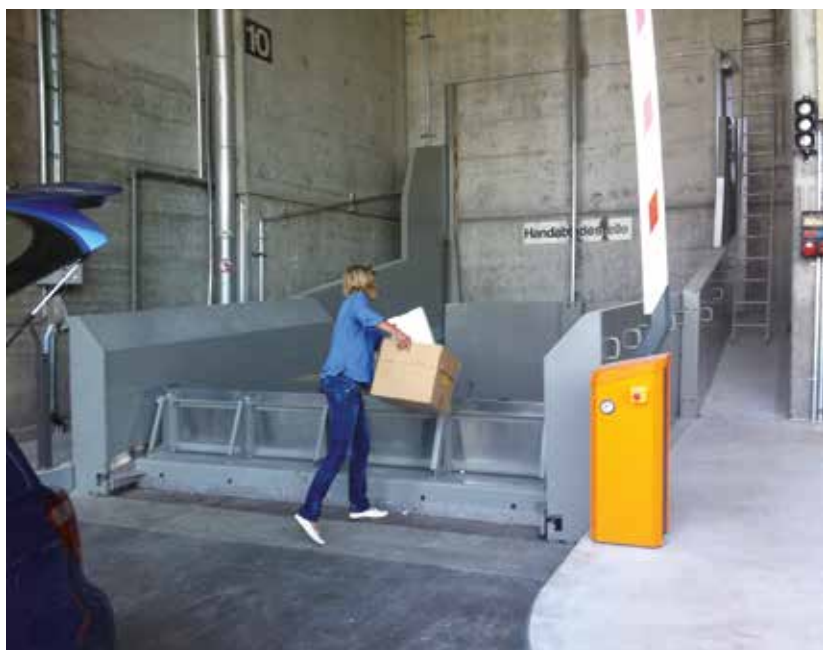
Privat-Anlieferstelle der KVA Buchs AG
