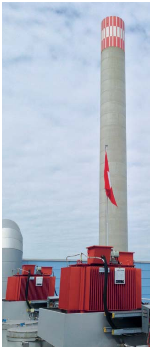
Spannungsversorgung Elektrofilter
