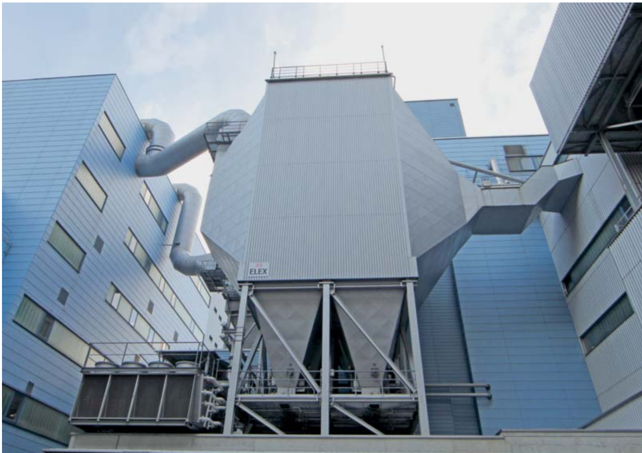
Elektrofilter Ofenlinie 2
