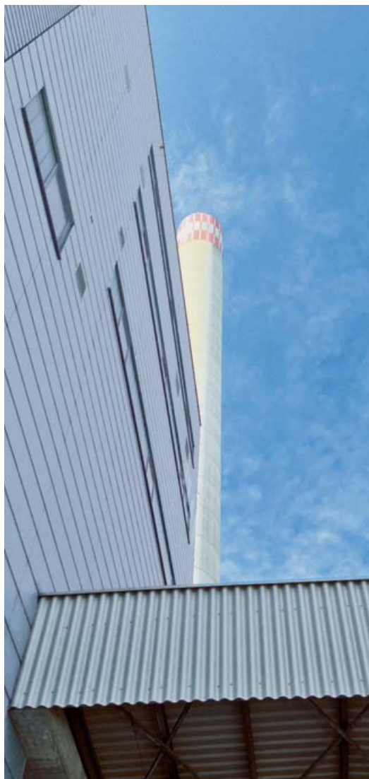
RGR-Gebäude mit Hochkamin
