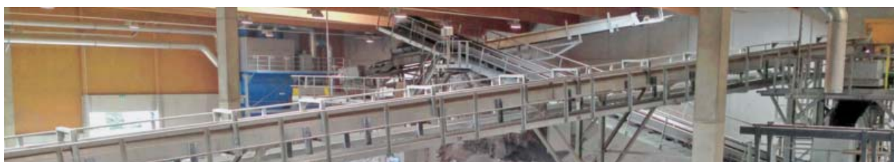
Fördersysteme in der NE-Halle
