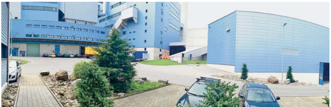
Blick auf KVA-Areal mit Ofenhaus, Rauchgasreinigung und NE-Halle
